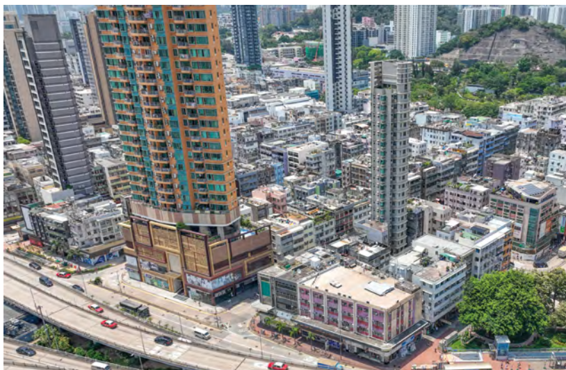
九龍城區「小區復修」先導計劃範圍鳥瞰圖。市建局透過提供適切的財政資助和技術支援，鼓勵業主進行樓宇復修，延長樓宇壽命。
